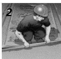
2 Posa 2 strato di geotessuto , posa e livellamento con eventuali pendenze della sabbia pulita o ghiaino ( spessore max 8 mm) con uno spessore che va dai 3 ai 6 cm
