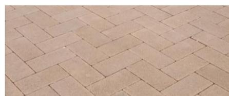
**POSA MULTICOLOR:** Nella fase di posa vengono assemblati 2 o più colori dello stesso formato mescolando il più possibile gli elementi che compongono la pavimentazione.
